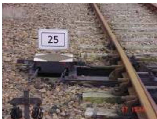
Wisselbediening met ketting en trekdraden
